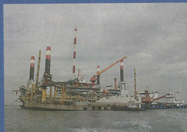
整平船故障搶修後完成第廿一節沉管基槽整平
